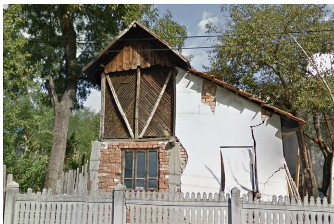
Strada laterală dreapta
