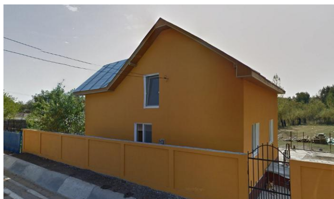
Strada laterală stânga
