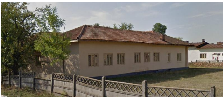
Strada laterală stânga
