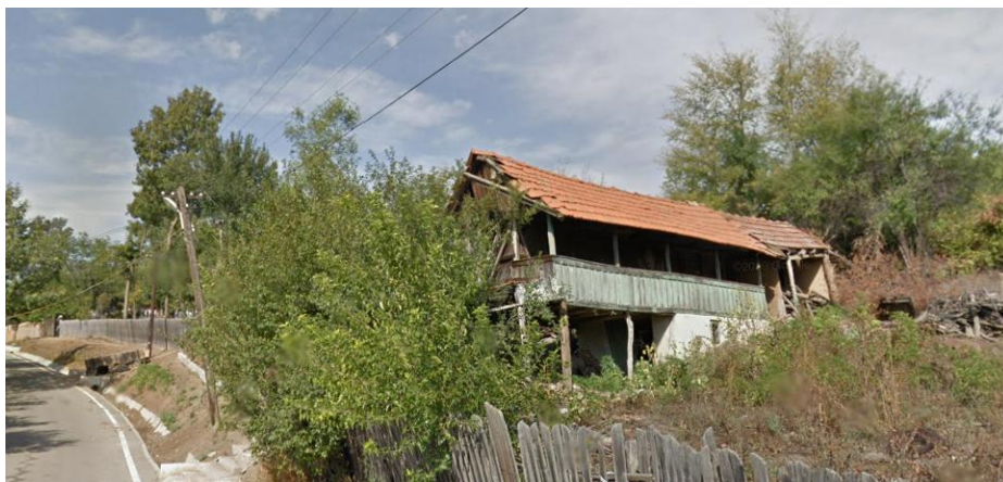
Strada laterală dreapta
