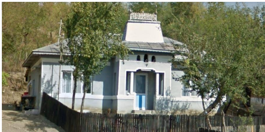
Strada laterală dreapta
