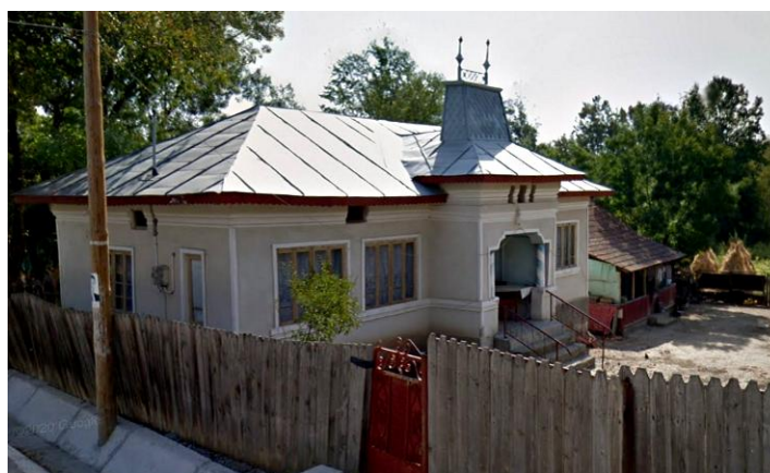
Strada laterală stânga
