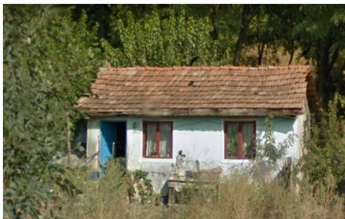
Strada laterală dreapta
