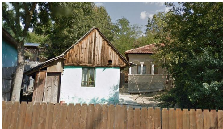
Strada laterală dreapta
