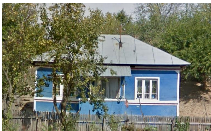
Strada laterală dreapta
