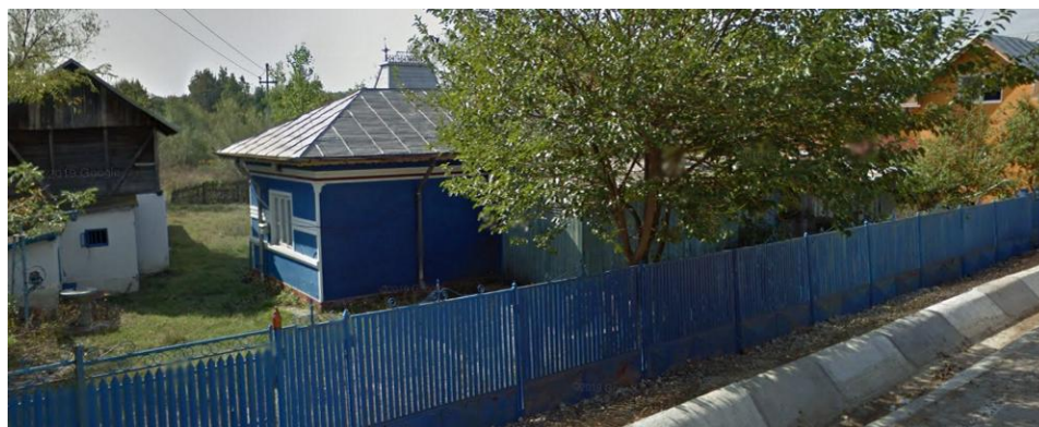
Strada laterală stânga
