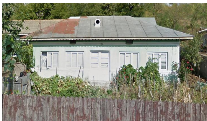
Strada laterală dreapta
